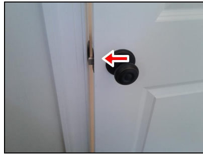
Laundry room door
