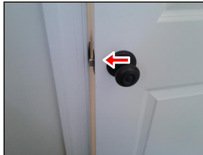
Laundry room door
